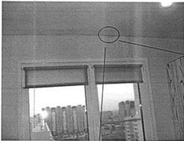
Фото 1. Кухня: Общий вид наружной стены
